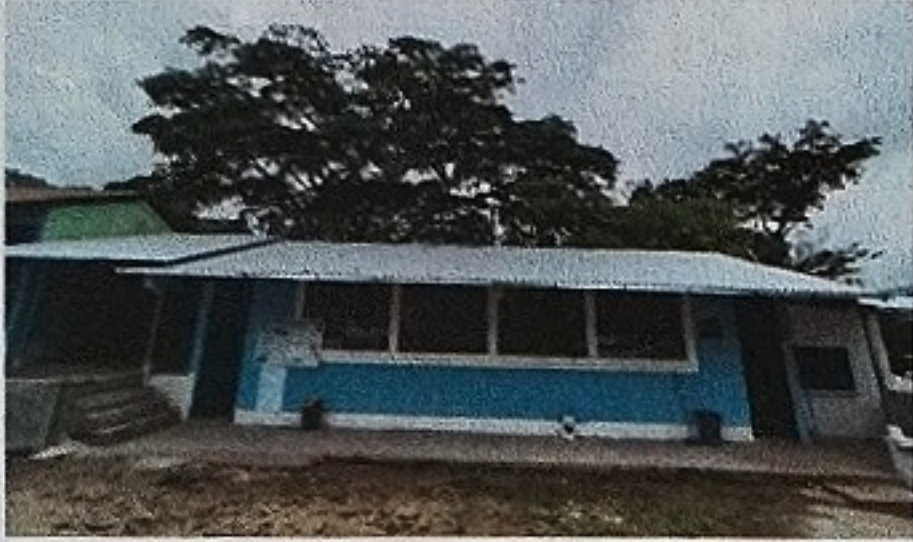
Foto 1: Finalización de colocación cubierta de techo con estructura
