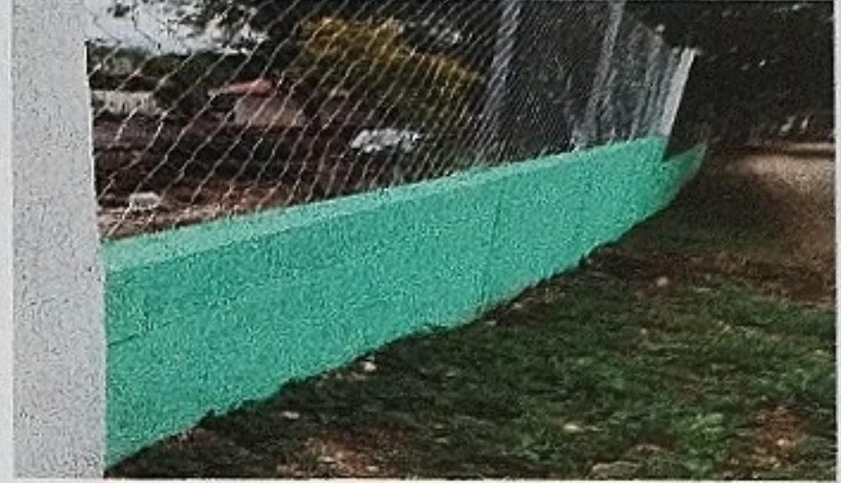
Foto 2: Finalización de mejoramiento de muro frente y costado del centro Educativo
